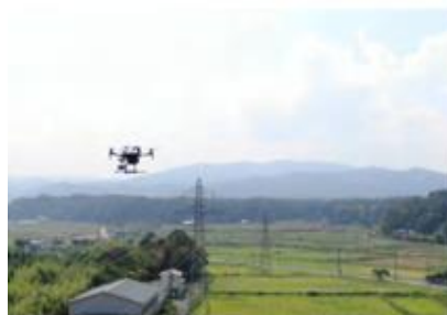
ドローンによる送電線の巡視状況
